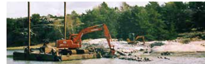
Muddring, Schakt- och sprängningsarbeten, Sten- och betongarbeten
